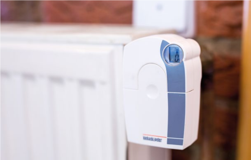
Eine Funk-Heizkörpersteuerung lässt sich individuell programmieren, so dass ausreichend Wärme zum richtigen Zeitpunkt da ist.
